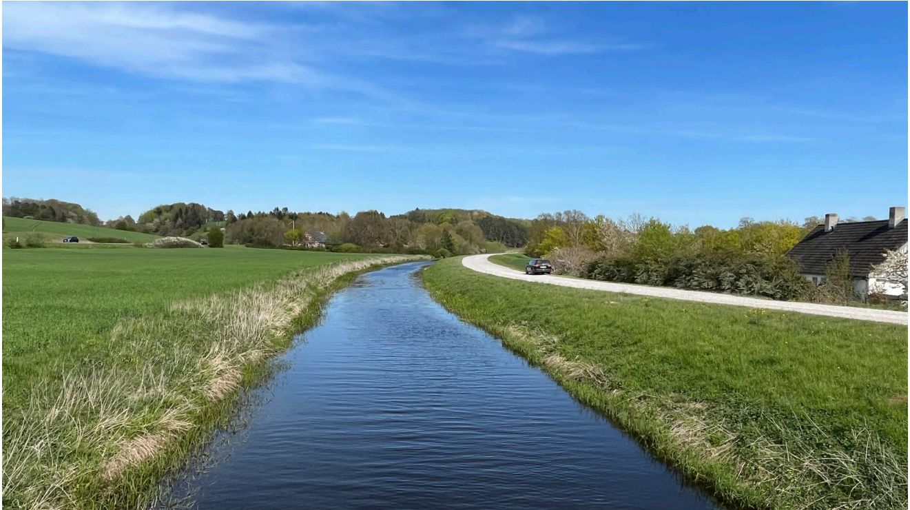
Figur 4.1: Landskabet er kendetegnet ved en enkelt struktur af kanaler, diger og grøfter, der afgrænser de drænedede marker. Billedet viser Nordkanalen og det nordlige dige, der sikrer vandet fra at trænge ind i området.
